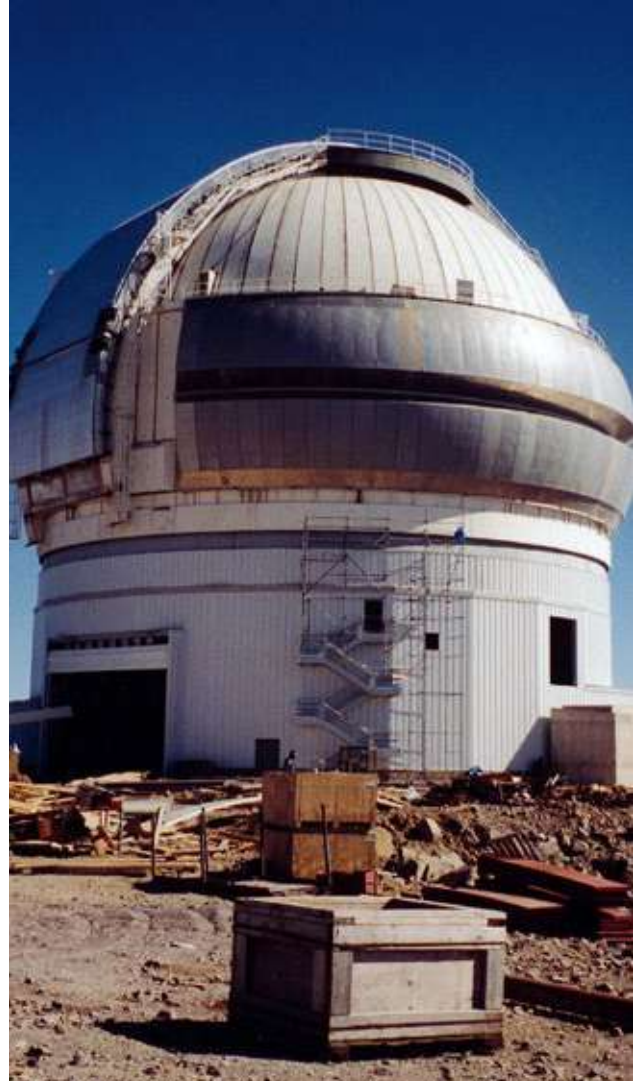
Construcción del telescopio Gemini Sur - de 8 m en Cerro Pachón (Región de Coquimbo, Chile) en el año 1998. Crédito: NOAO/AURA/NSF.
